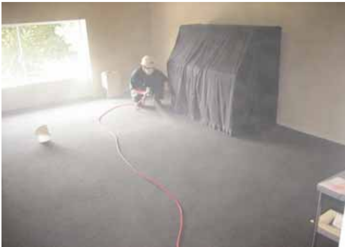
銀系光触媒イーデンフラッシュ EDF による施工模様（練習室 ・床・壁・天井）
