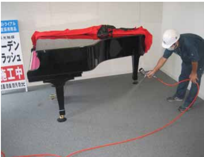
銀系光触媒イーデンフラッシュ EDF による施工模様（練習室 ・床・壁・天井）
