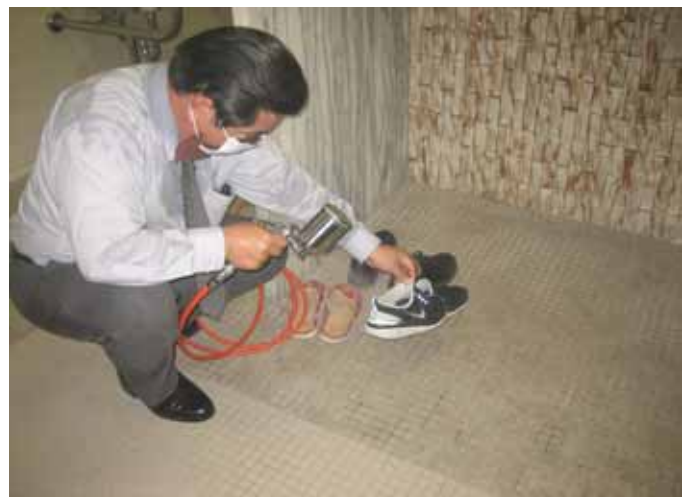
銀系光触媒イーデンフラッシュ EDF による施工模様（女子トイレ・床・壁・便器・洗面所）
