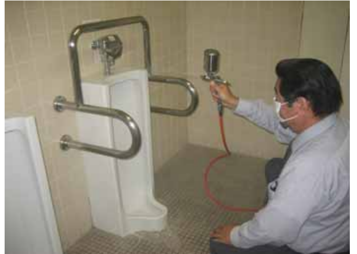
銀系光触媒イーデンフラッシュ EDF による施工模様（男子トイレ・床・壁・便器・洗面所）
