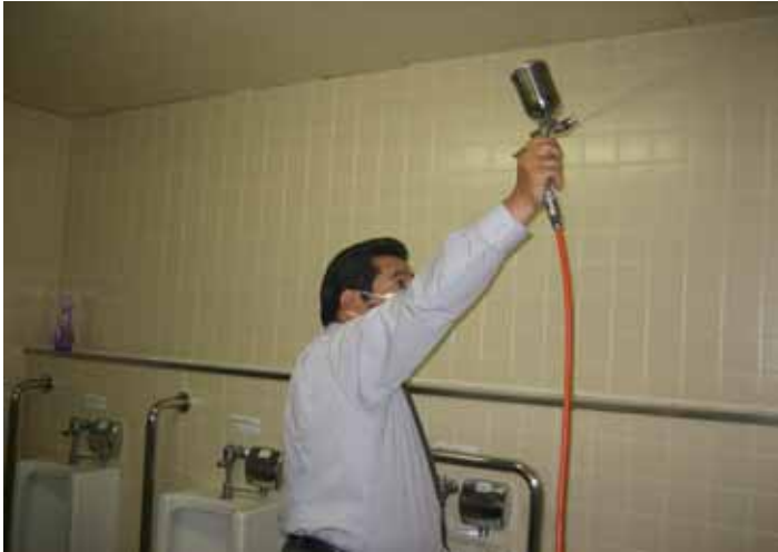
銀系光触媒イーデンフラッシュ EDF による施工模様（男子トイレ・床・壁・便器・洗面所）
