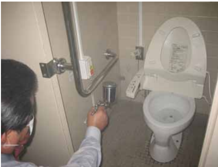
銀系光触媒イーデンフラッシュ EDF による施工模様（女子トイレ・床・壁・便器・洗面所）
