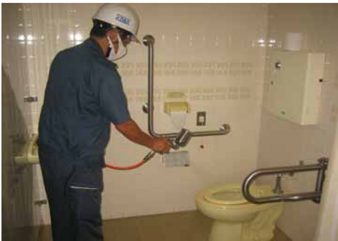
銀系光触媒イーデンフラッシュ EDF による施工模様 (風除室・玄関)
