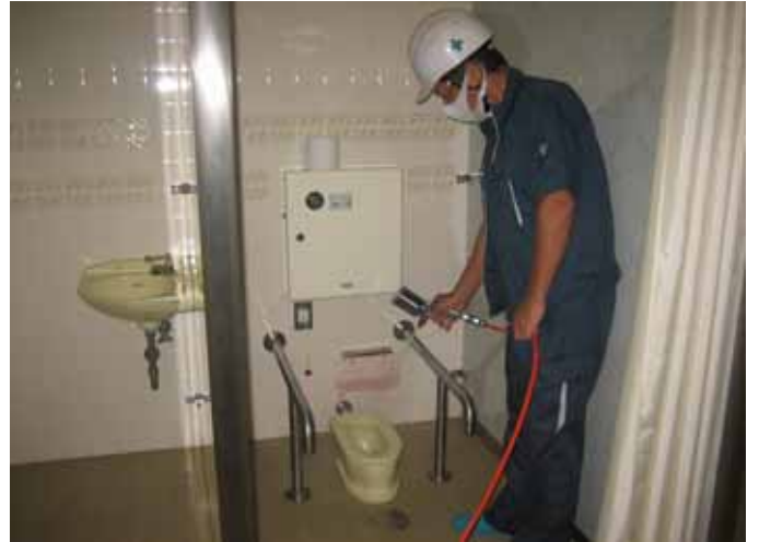
銀系光触媒イーデンフラッシュ EDF による施工模様 (トイレ・床・壁・天井・便器)
