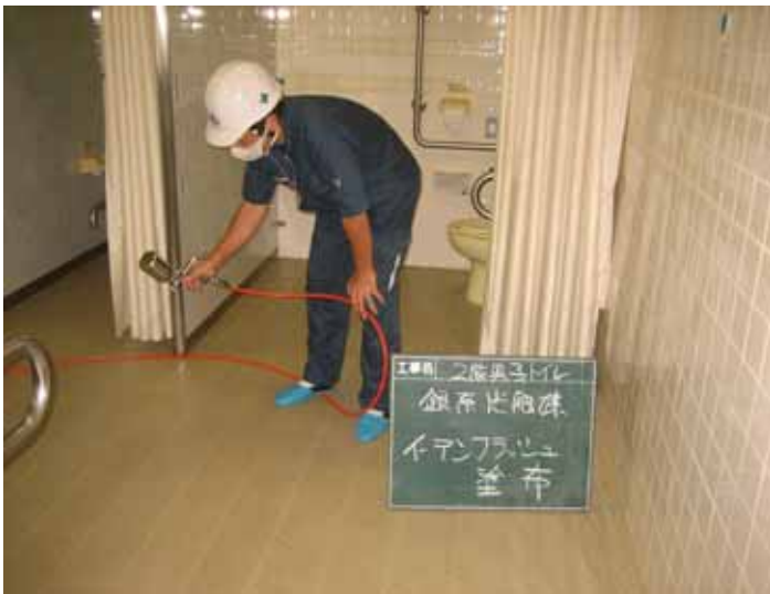
銀系光触媒イーデンフラッシュ EDF による施工模様 (トイレ・床・壁・天井・便器)
