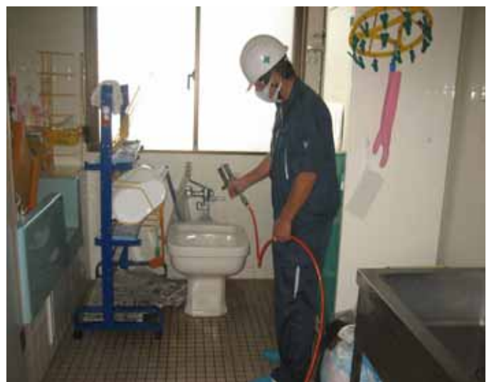
銀系光触媒イーデンフラッシュ EDF による施工模様 (トイレ・床・壁・天井・便器)
