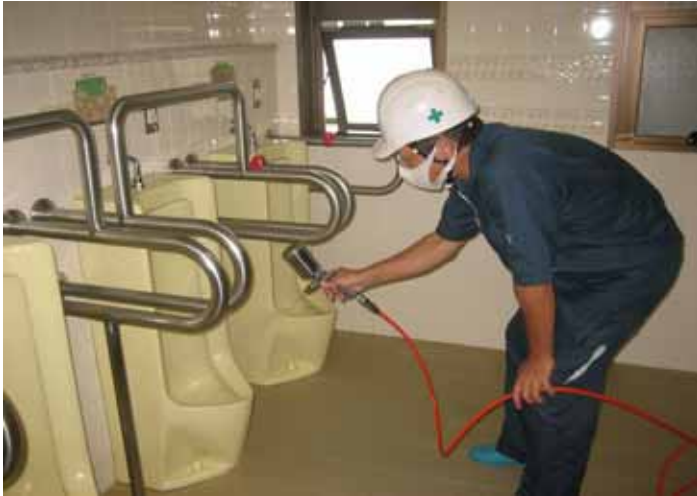
銀系光触媒イーデンフラッシュ EDF による施工模様 (トイレ・床・壁・天井・便器)
