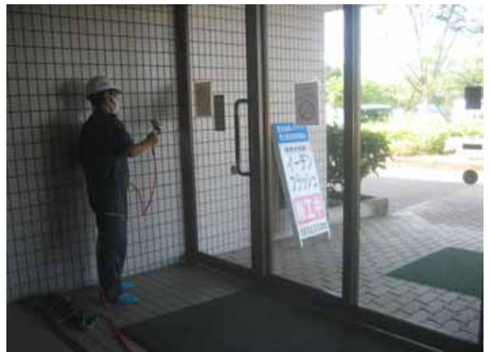
銀系光触媒イーデンフラッシュ EDF による施工模様 (風除室・玄関)
